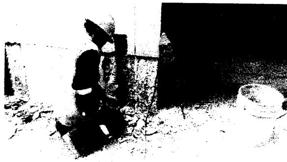
Foto 19 y 20: Picado en muros de ladrillos y concreto armado para salidas de interruptores, tomacorrientes y otras salidas eléctricas. ILEE - ZONA DE ALAMCEN Y EXTERIOR DE DESCARGA
