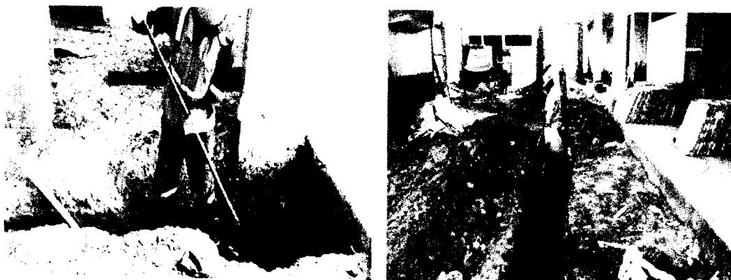
Foto 03 y 04: Excavaciones de zanjas y ductos para instalaciones eléctricas. PATIO DE MANIOBRAS E INTERIOR DE TAREAS PREVIAS
