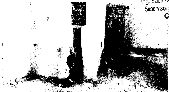
Foto 17 y 18: Picados de muros y sobrecimientos en interiores para las salidas de interruptores, caja pase, tableros y otras salidas eléctricas. I.I.EE- ZONA DE TAREAS PREVIAS Y ZONA DE FRIO
