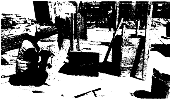
Foto 87 y 88: Encofrado y desencofrado de cajas eléctricas y ductos. INTALACIONES ELECTRICAS BAJA TENSION
