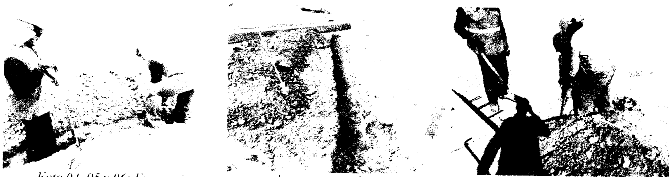
Foto 04, 05 y 06: Excavaciones y acarreo de estructuras de concreto simple y terreno natural de zanjas para instalaciones de tuberías eléctricas. PATIO DE MANIOBRAS
