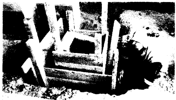
Foto 89 y 90: Encofrado y desencofrado de cajas eléctricas y ductos. INTALACIONES ELECTRICAS BAJA TENSION
