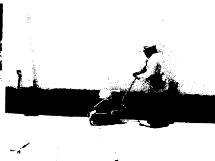
Foto 21, 22 y 23: Relleno y Compactación de zanjas con material afirmado y material propio. PATIO DE MANIOBRAS
