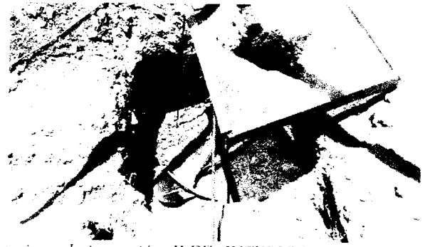
Foto 11 y 12: Excavación de cajas eléctricas en interiores y exteriores baja tensión. I.I.EE- INTERIOR DE TAREAS PREVIAS Y PATIO DE MANIOBRAS
