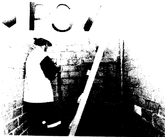
Foto 19 y 20: Picado en muros de ladrillos y concreto armado para salidas de interruptores, tomacorrientes y otras salidas eléctricas. ILEE - ZONA DE ALAMCEN Y EXTERIOR DE DESCARGA
