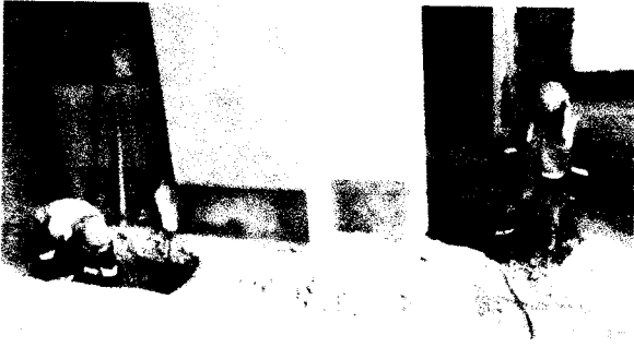
Foto 11 y 12: Excavación de cajas eléctricas en interiores y exteriores baja tensión. I.I.EE- INTERIOR DE TAREAS PREVIAS Y PATIO DE MANIOBRAS
